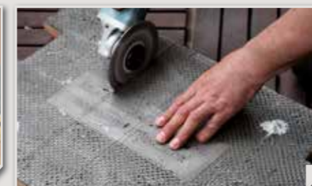
3. Pokud je potřeba provést úpravu rozměru obkladového panelu použijeme úhlovou brsku
